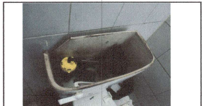
Foto 6: sustitucion de inodoro
