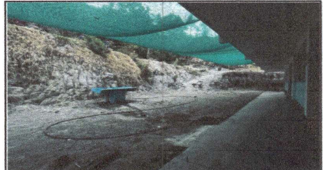
Foto 4: Reparación de piso de torta de concreto espesor 0.10 cm.
