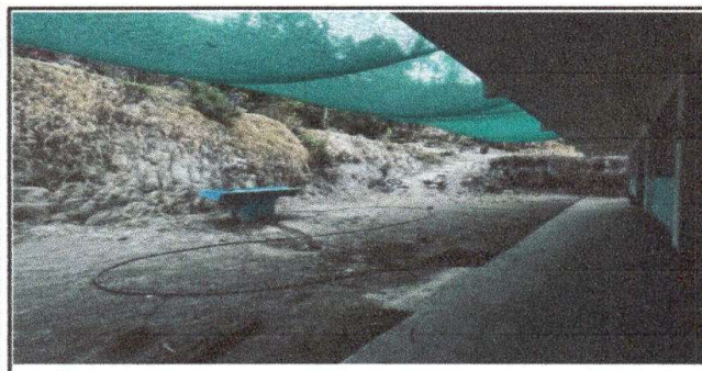
Foto 5: cuneta de concreto
