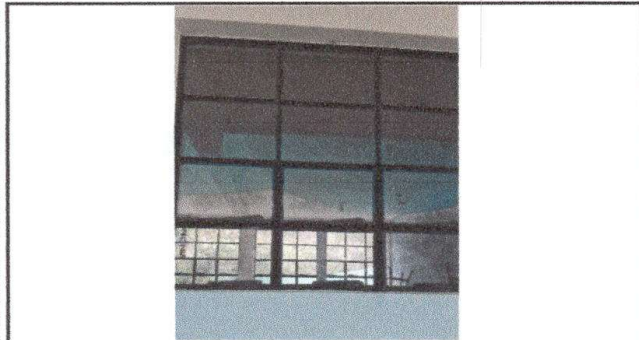
Foto 3: sustitución de balcones
